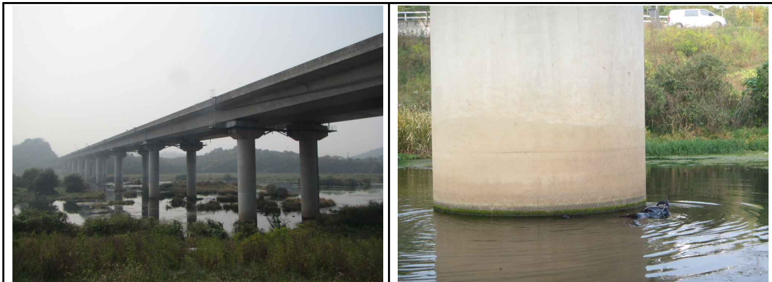
금호강교 전경 및 조사대상 교각
