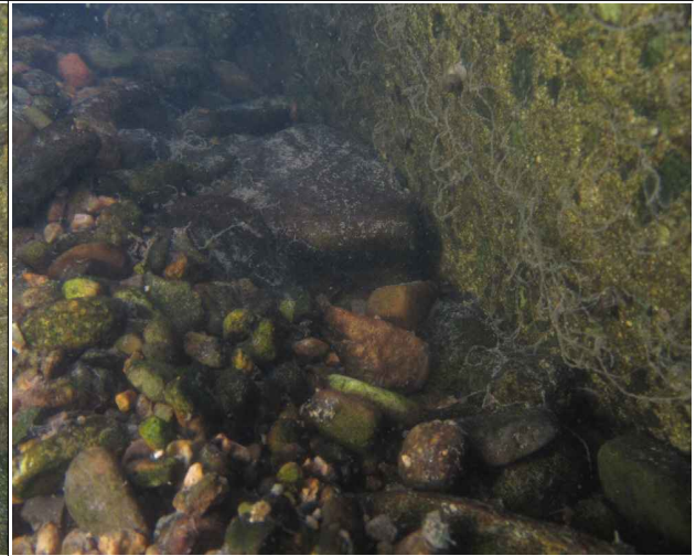
P13하행 교각 기초저면, 상태 양호
