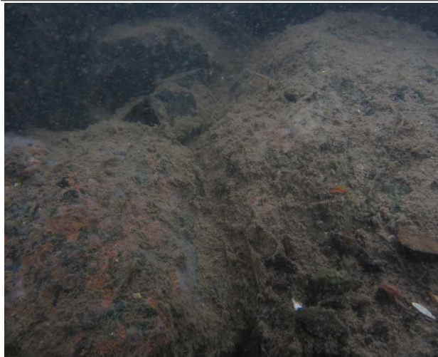
P15하행 교각 보호사석, 상태 양호
