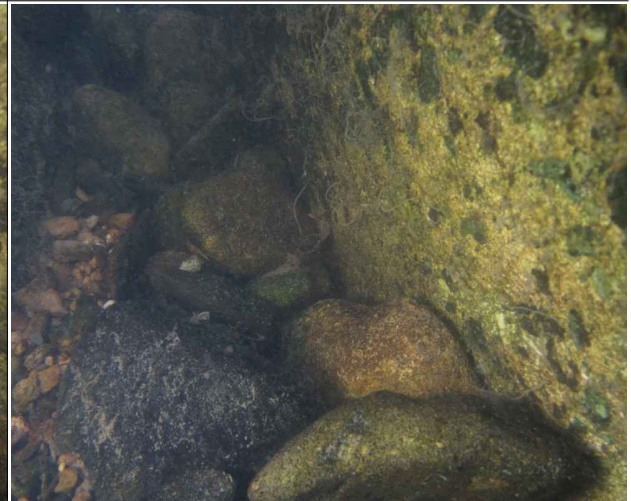
P13하행 교각 기초저면, 상태 양호
