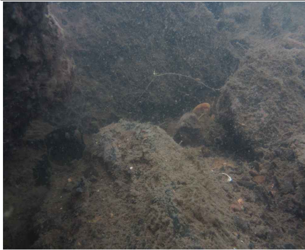
P15하행 교각 보호사석, 상태 양호
