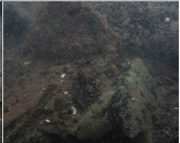
P15하행 교각 보호사석, 상태 양호
