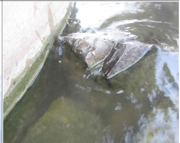
P13상행 교각 보호사석, 상태 양호
