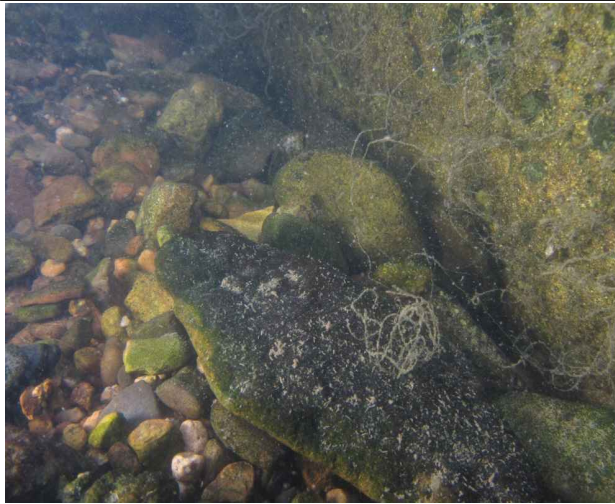
P13하행 교각 기초저면, 상태 양호
