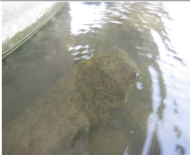
P13상행 교각 보호사석, 상태 양호
