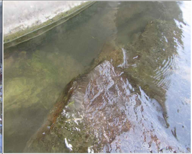
P13상행 교각 보호사석, 상태 양호
