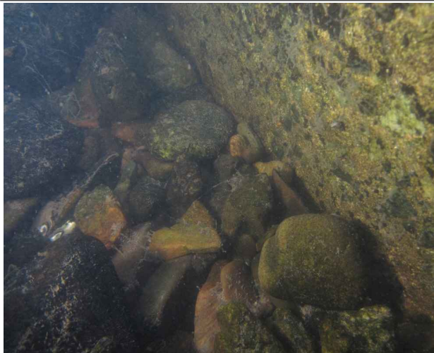
P13하행 교각 기초저면, 상태 양호
