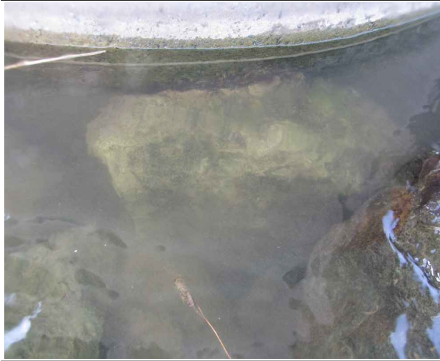
P13상행 교각 보호사석, 상태 양호
